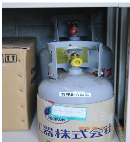
4-41 LP ガスボンベ 10 kg 数量 1 台 重量(容量 10 kg+容器 11 kg) 4-42 LP ガスボンベ 5 kg 数量 1 台 重量(容量 5 kg+容器 7.5 kg)
