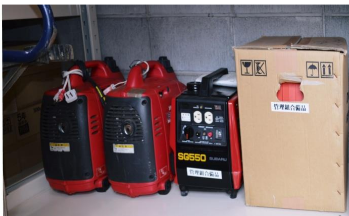
4-12 (左) ガソリン式発電機 数量 2 台 (HONDA 恵贈分 2 台) 4-11 (中) ガソリン式発電機 数量 1 台 →SUBARU2023.2.26 作動せず、故障 4-3 (右) LP ガス式発電機 数量 1 台 取説有り
