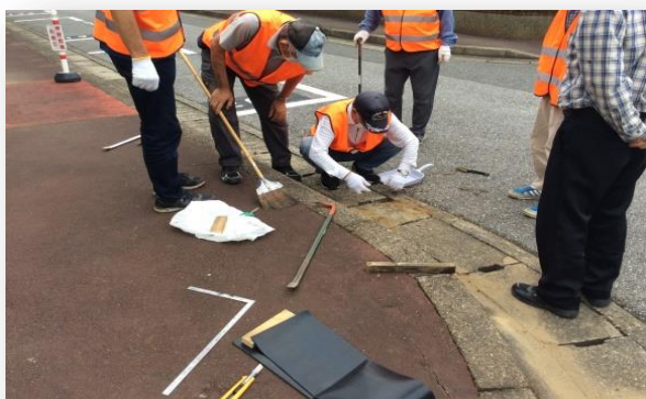
7月30日 5棟前U字溝ガタガタ補修
